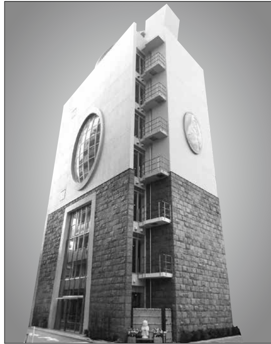
京急川崎駅前にオープンした屋内墓苑「真應殿」 2013年11月にオープン
