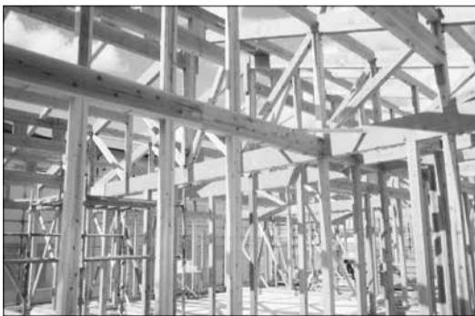
国産にこだわる梅谷仏具店新工場の構造材は 国産の檜と杉
