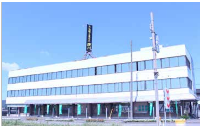
店舗外観 (廣川仏壇店・本社ショールーム)
